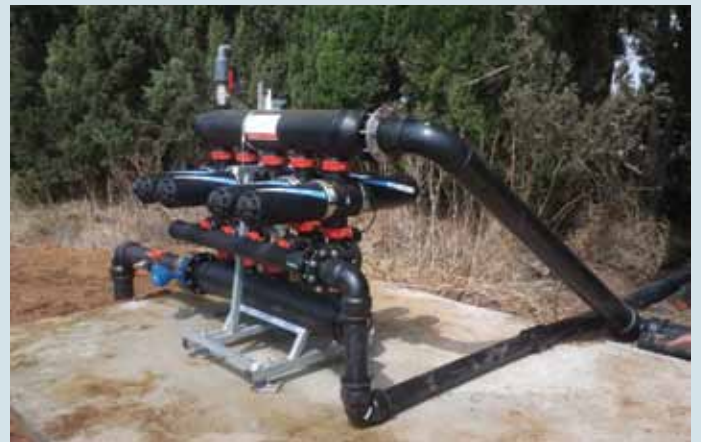
מערכת ל-200 מק"ש מים ממוחזרים מטעי המעפיל
