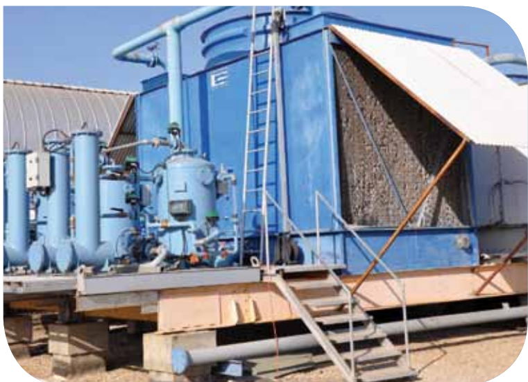
מערכת משולבת מפנה אבנית ומסננים בבית הדפוס של ידיעות אחרונות
