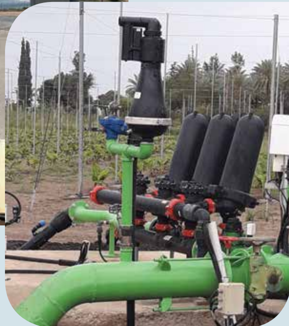
אריסנס מותקן על גבי מערכת סינון
