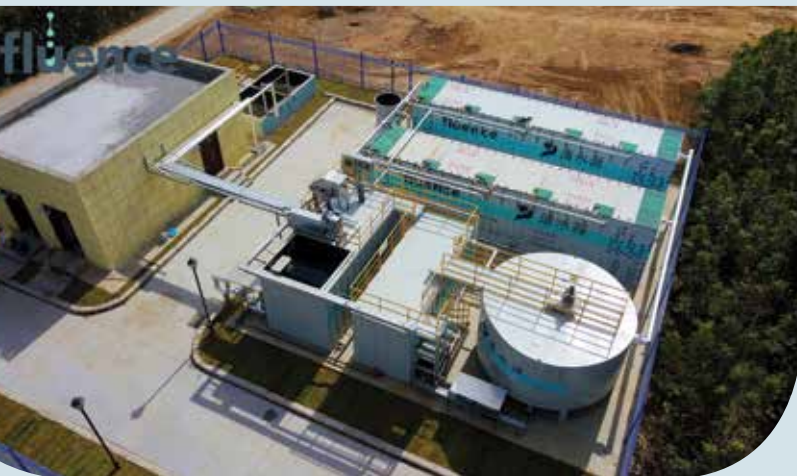
מתקן טיהור שפכים מבוסס מערכות מודולריות מסוג Aspiral של פלואנס – המערכות מספקות פתרון מתקדם ויעיל אנרגטית לטיפול בשפכים המאפשר שימוש חוזר לצורך השקיה והשבה לטבע
